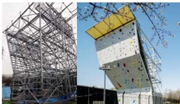
メタルプロダクツが手掛けた施設の一例。都内初の総合クライミング施設「葛飾区東金町運動場スポーツクライミングセンター」。
