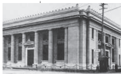
大正12年8月に竣工した本店建物
