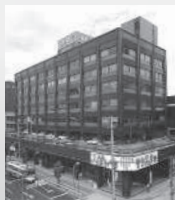
昭和46年に 竣工した 本店ビル
