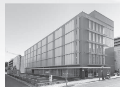
令和3年8月に竣工した旅籠町ビル
