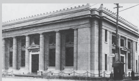
大正12年8月に竣工した本店建物
