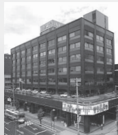
昭和46年に 竣工した 本店ビル
