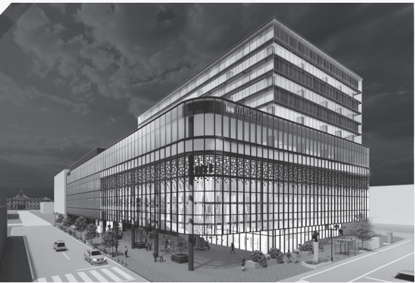
公益的施設も備えた新本店ビル(2026年春頃完成予定)
