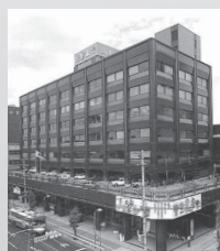
1971年(昭和46年) 七日町旧本店ビル全館竣工
