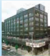
1971年(昭和46年) 七日町旧本店ビル全館竣工
